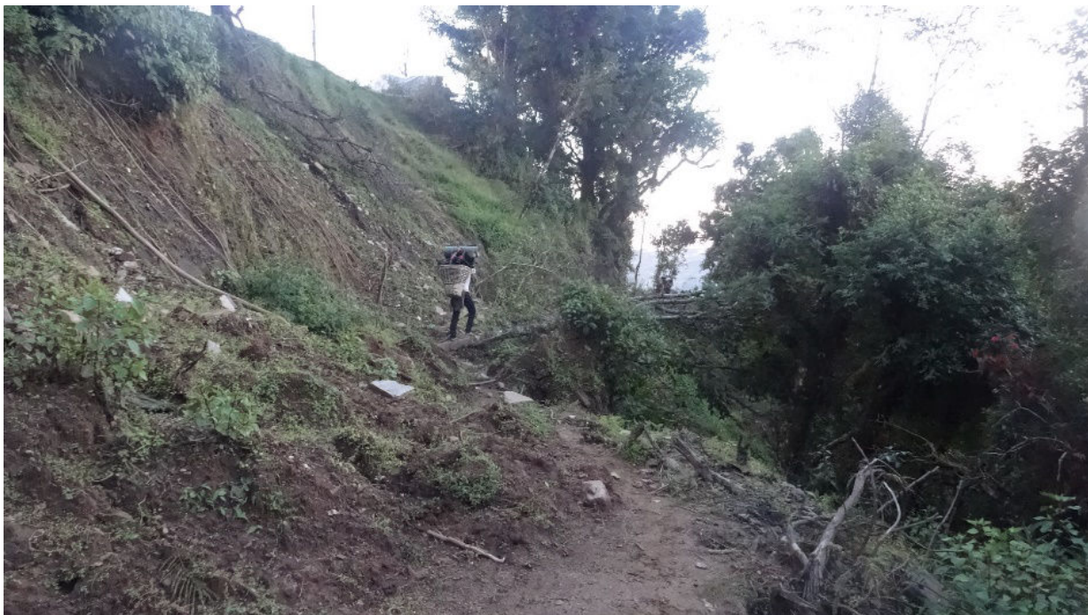
Voie d'accès au village par l'ouest, détruite par la mousson, le 30 octobre 2017
